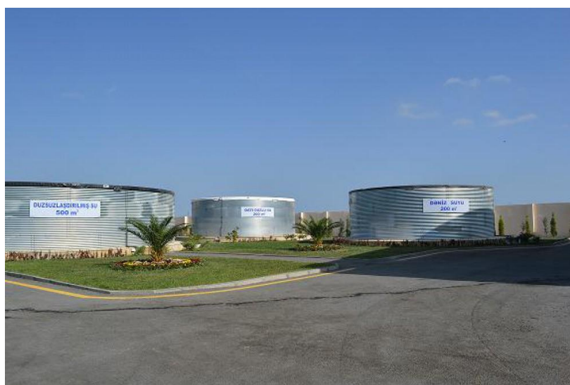
Şəkil 1. Salyan rayonu Xıdırlı kəndindəki dəniz suyunu içməli su kimi təmizləməyə imkan verə bilən kompleks
