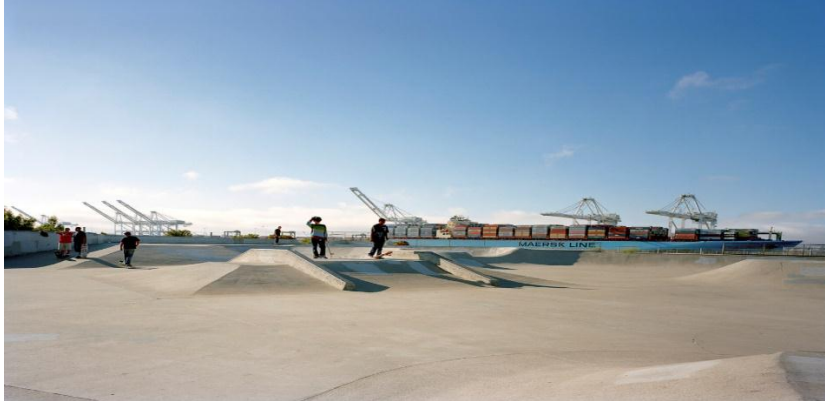
Şəkil.1 Geosintetik və beton qatı ilə örtülüb olan ərazilər yenidən istifadəyə yararlıdır. (Alamada, Kaliforniya)
